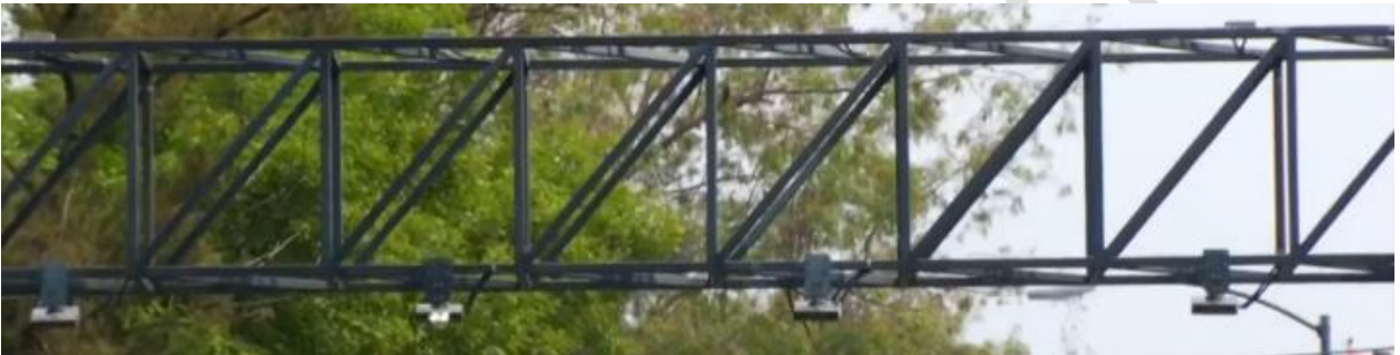
Arco de Detección con 4 cámaras especiales de placas de los vehículos.
